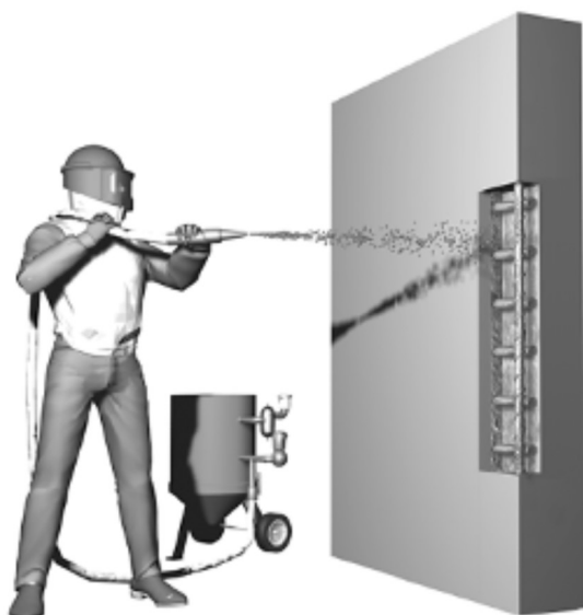
Remoção da corrosão com jateamento abrasivo
