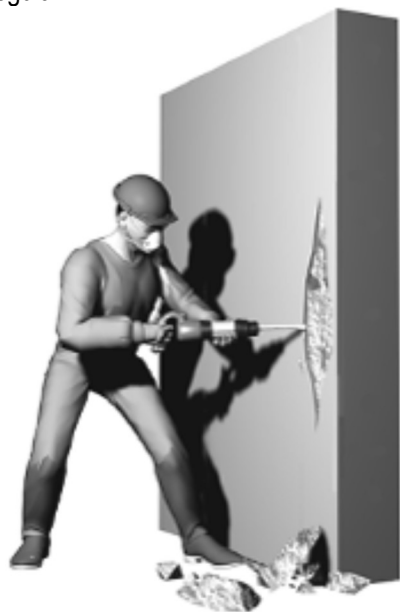
Demolição superficial do concreto
